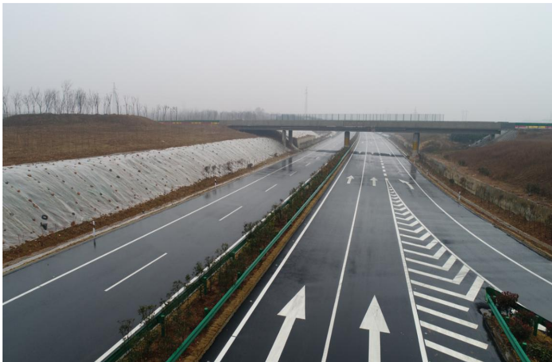
中心分隔带植物措施防护及路堑边坡临时苫盖措施
