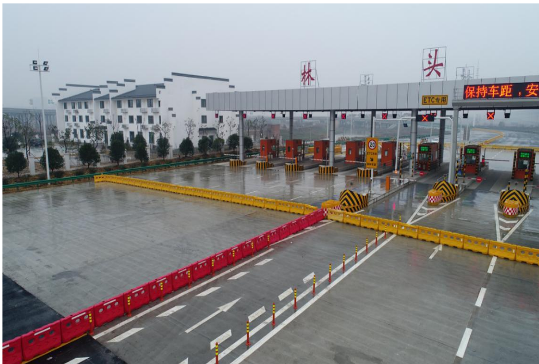
服务管理设施区乔灌木植物措施防护
