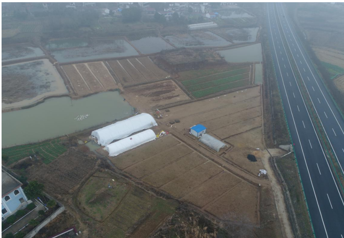
取土区土地整治后恢复现状
