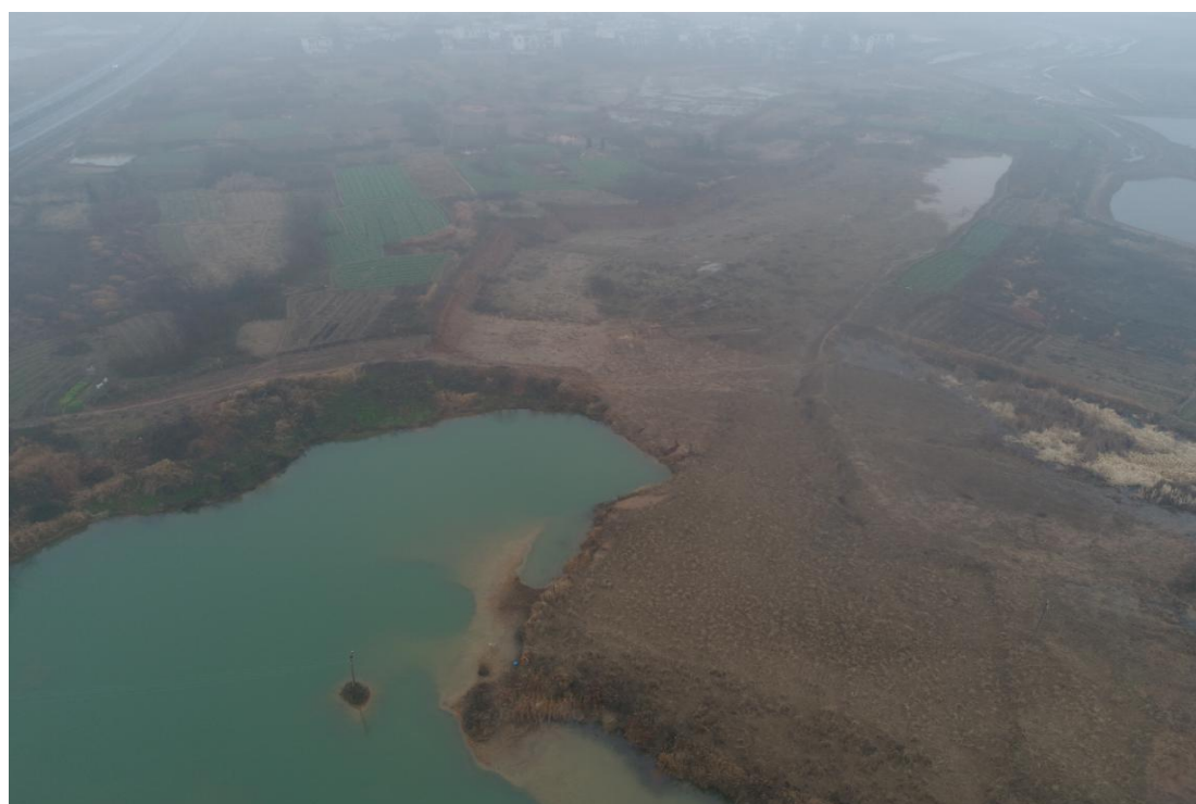
取土区土地整治后恢复现状
