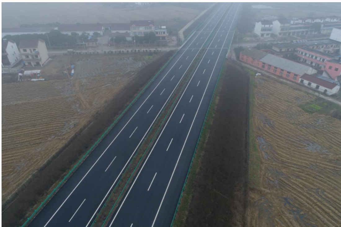
路基工程区边坡植物措施防护现状
