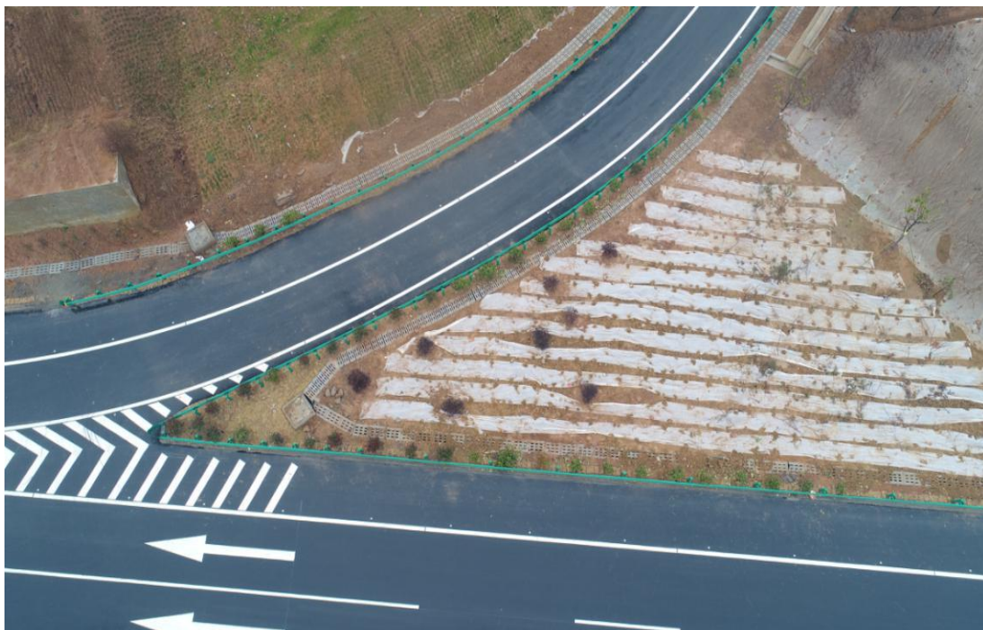
互通工程区灌草植物措施防护及临时苫盖措施
