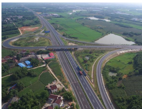
互通立交绿化景观现场情况
