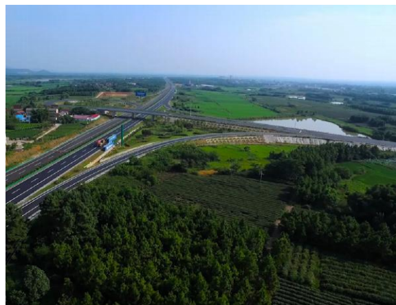
互通立交绿化景观现场情况
