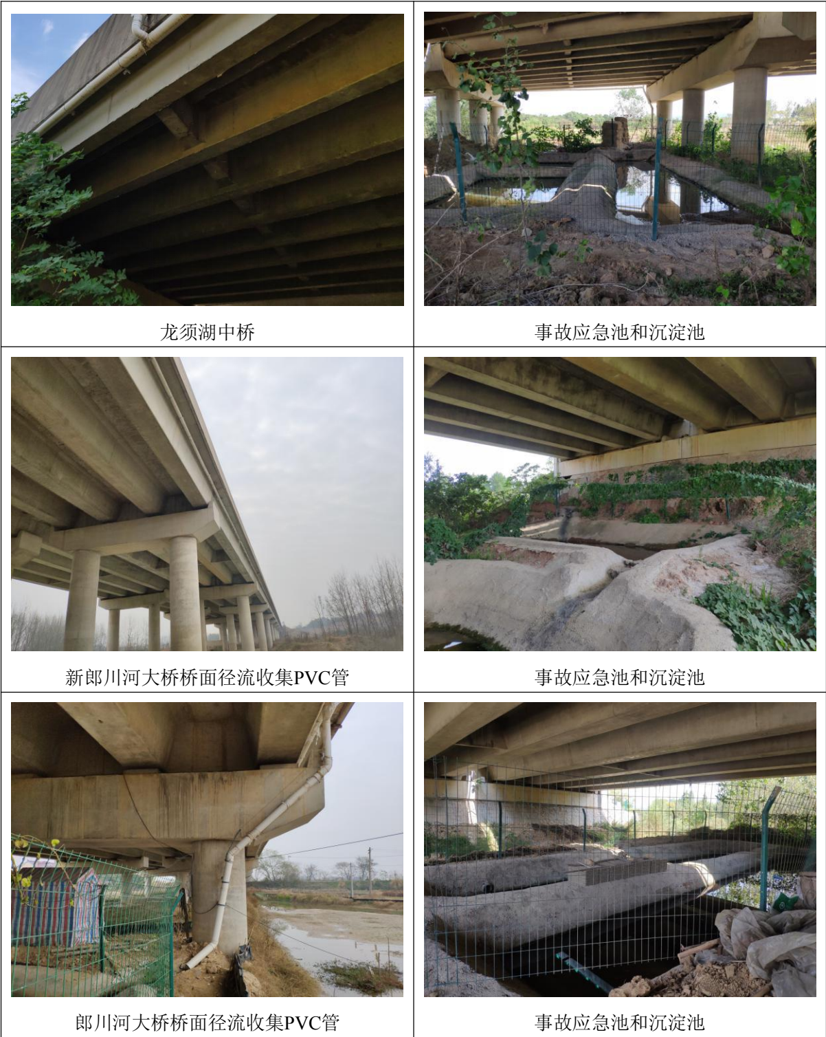
图 9-5 桥面径流收集及应急池
