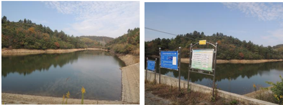
图 8-4 凤凰山水库现场情况
