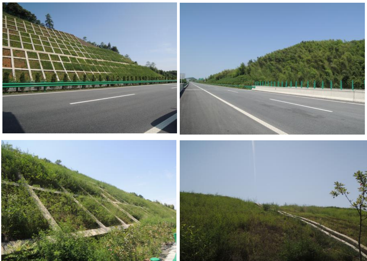
图 6-2 工程边坡防护、绿化现场情况
