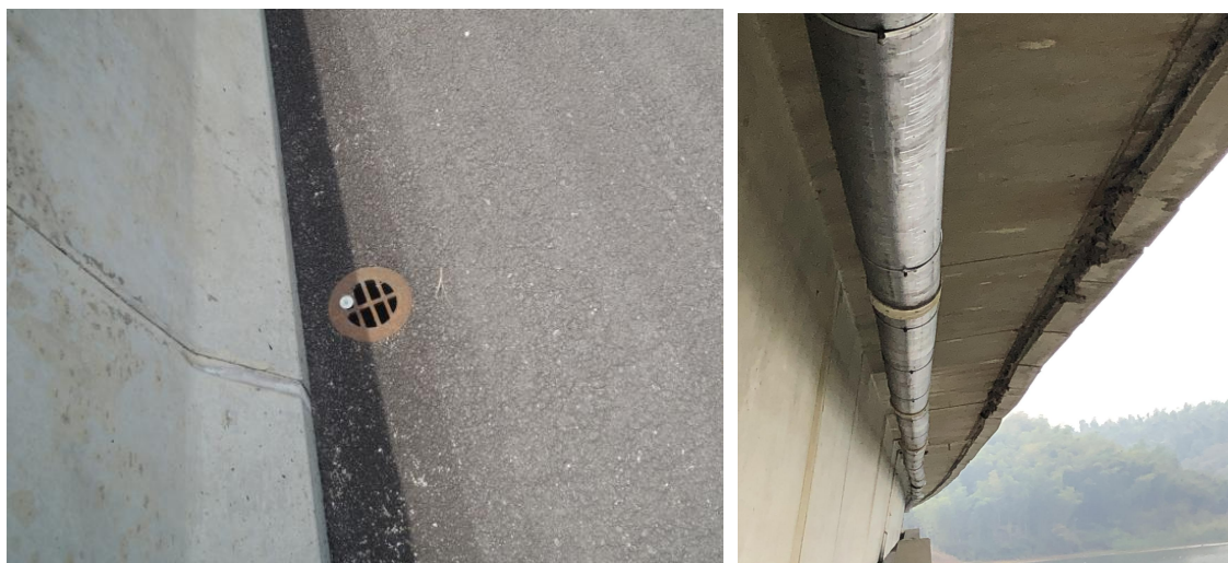
图 6-3 排水工程现场照片
