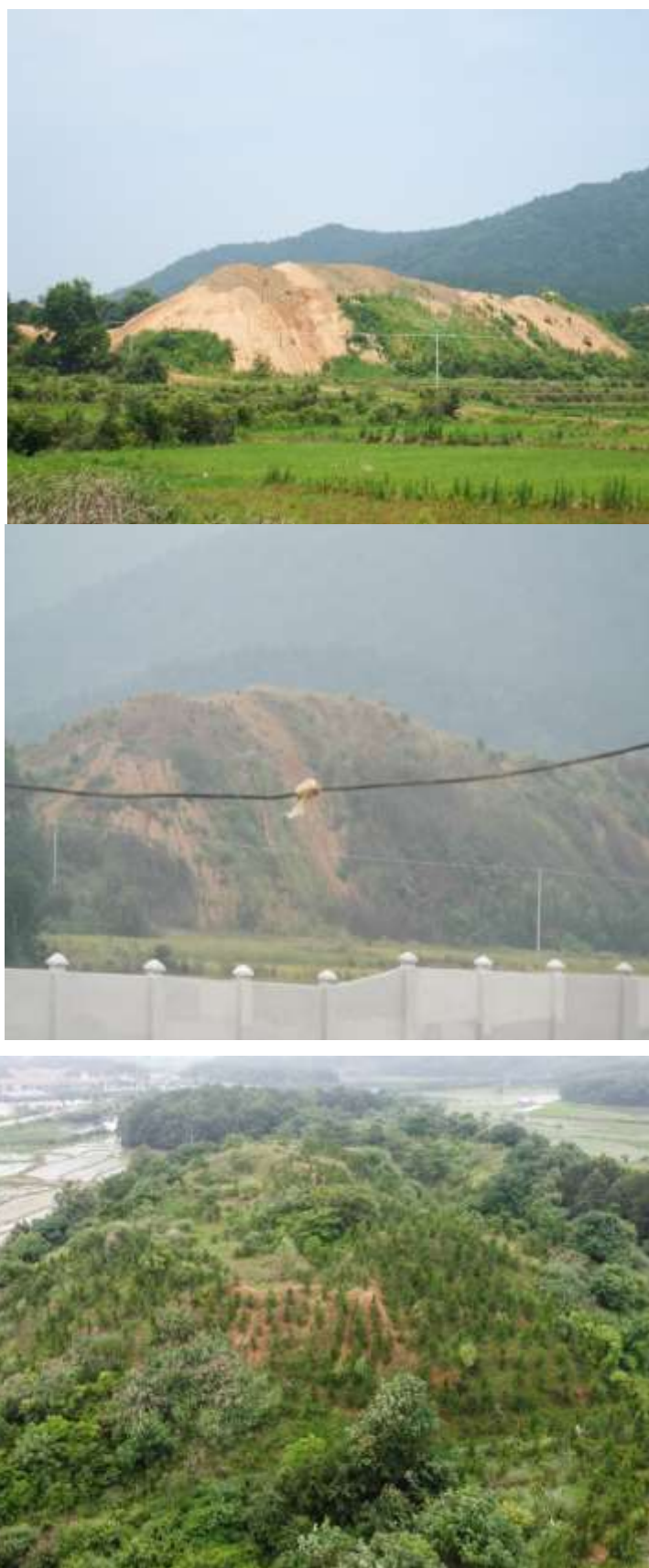
K20+080 弃土场施工期、施工后期及现状照片
