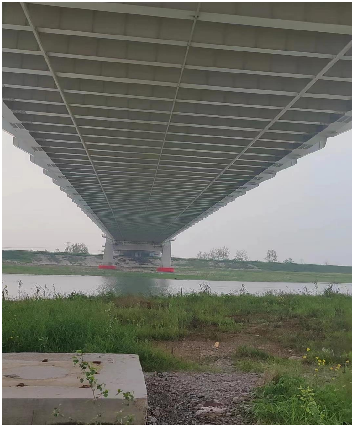
图 5.3-2 平水期秋浦河大桥现场照片（无桥墩涉水）
