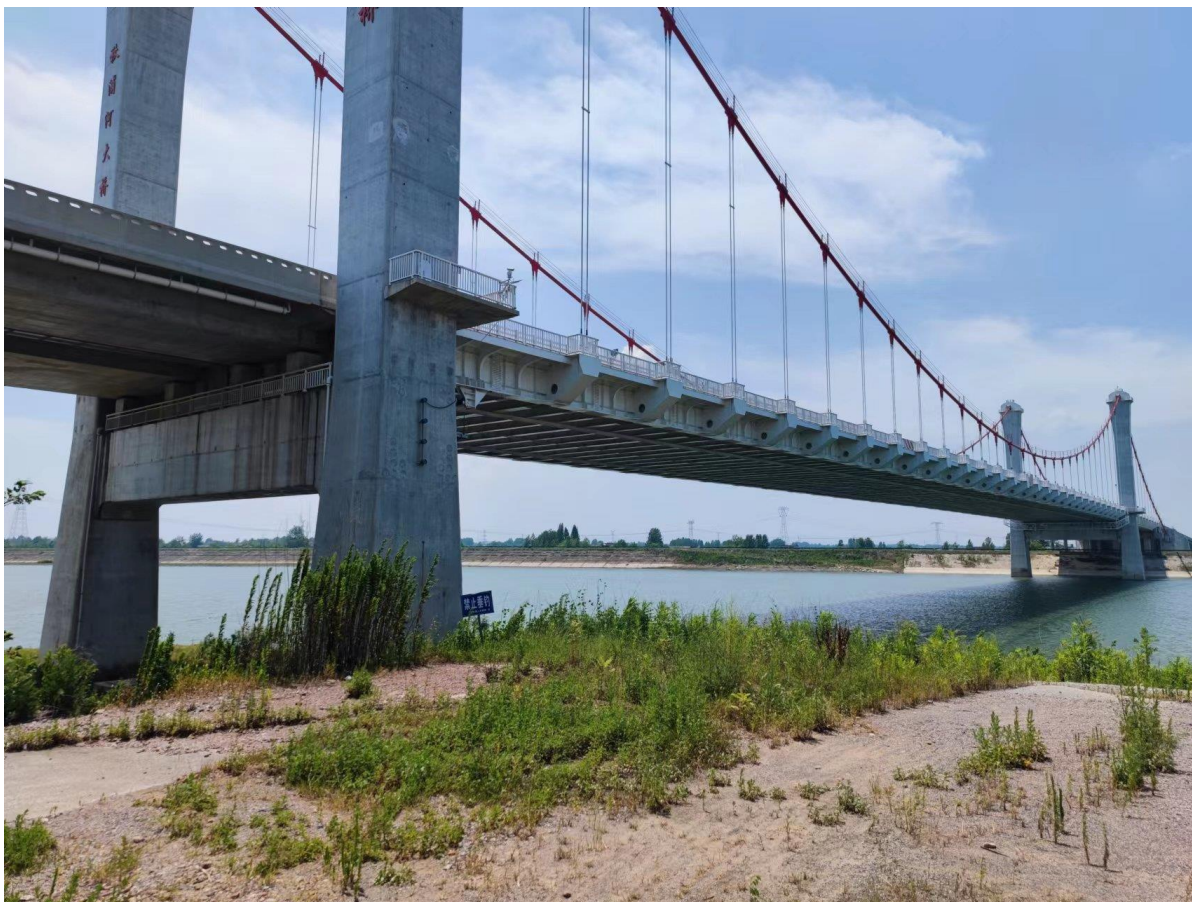
图 5.3-3 丰水期秋浦河大桥现场照片（仅南侧索塔涉水）
