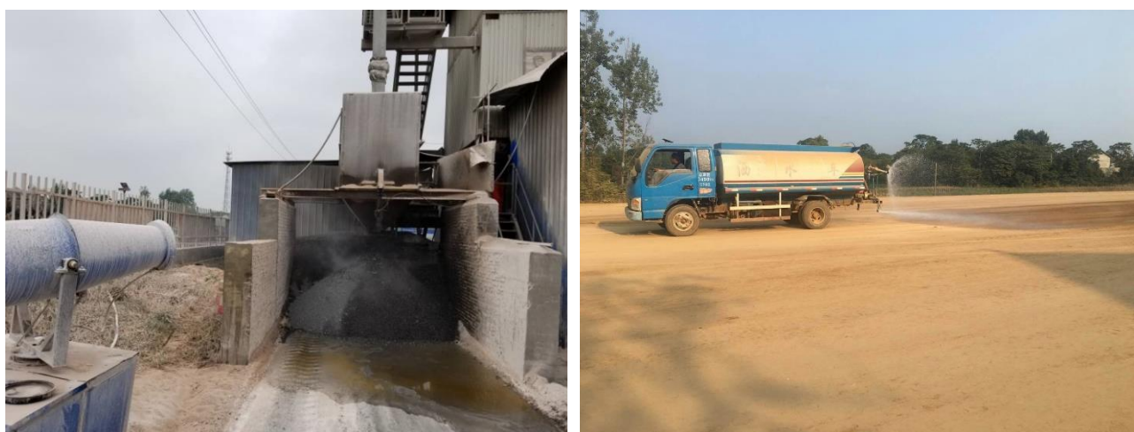
图 7.1-1 池州长江公路大桥施工期环境空气保护措施
