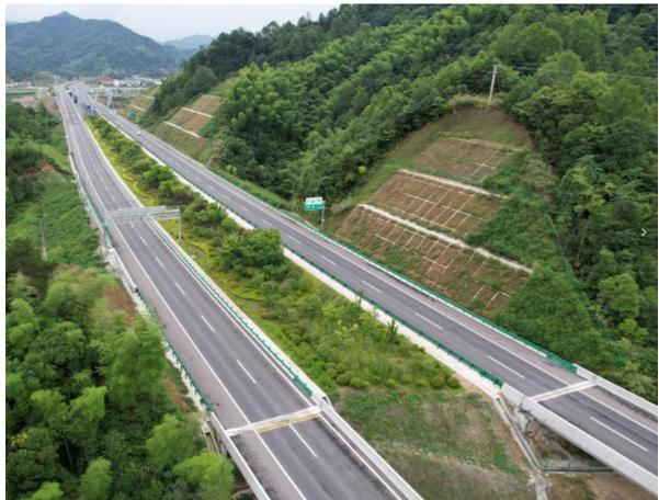
梨树岭段弃渣用于路面结构、边坡防护工程
