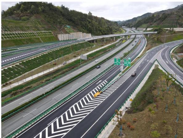
呈村降互通段弃渣用于路基填方、边坡防护工程
