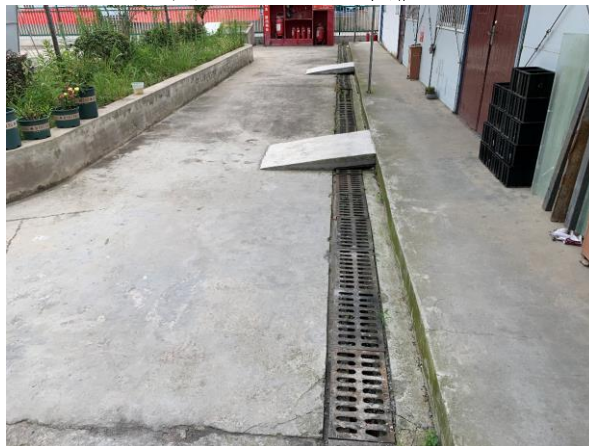
施工场地临时排水
