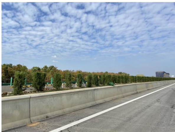
路基工程区中央分隔带绿化
