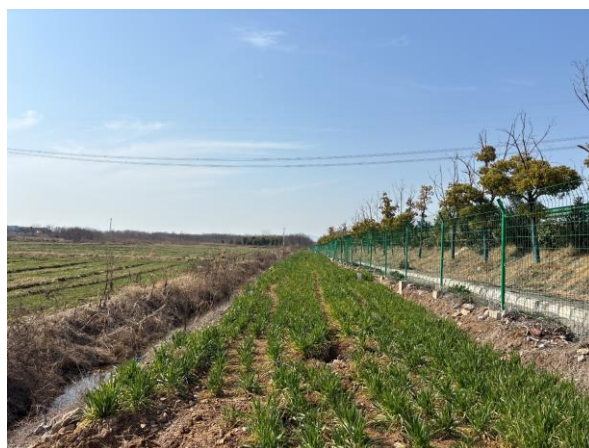
施工便道表土回覆、土地整治
