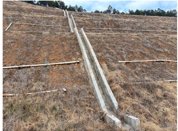
路基工程区高边坡急流槽
