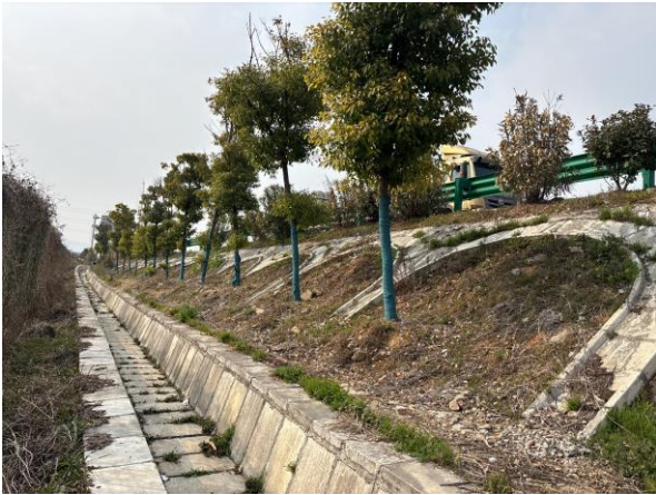
路基工程区拱形护坡及排水
