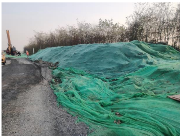
路基工程区临时堆土苫盖
