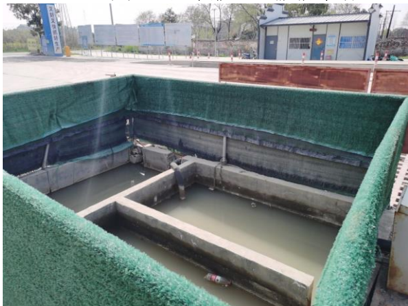
施工场地临时沉沙池
