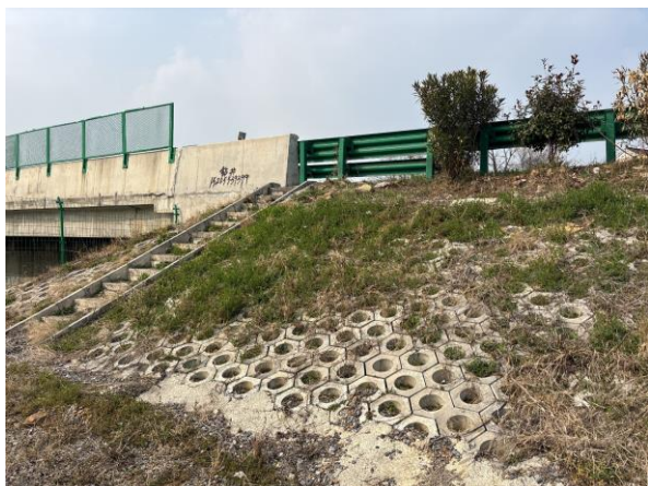
桥梁工程绿化
