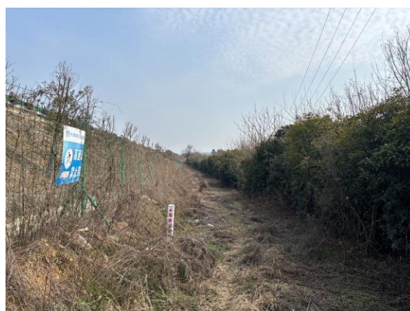
施工便道撒播草籽恢复
