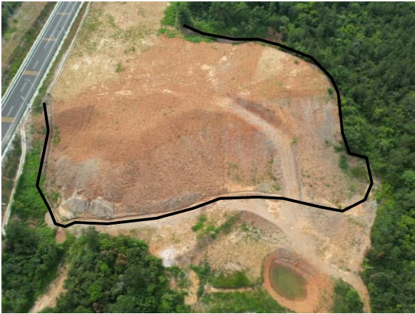
弃渣场排水沟开挖
