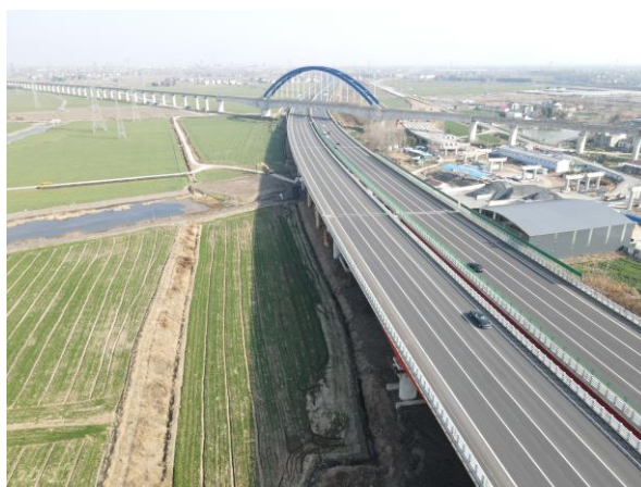
牛屯河特大桥下表土回覆、土地整治
