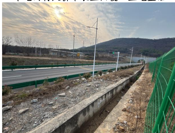
路基工程区排水
