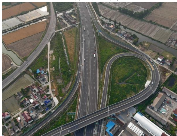
交叉工程区绿化 1
