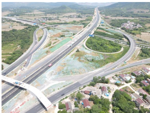
交叉工程区临时苫盖
