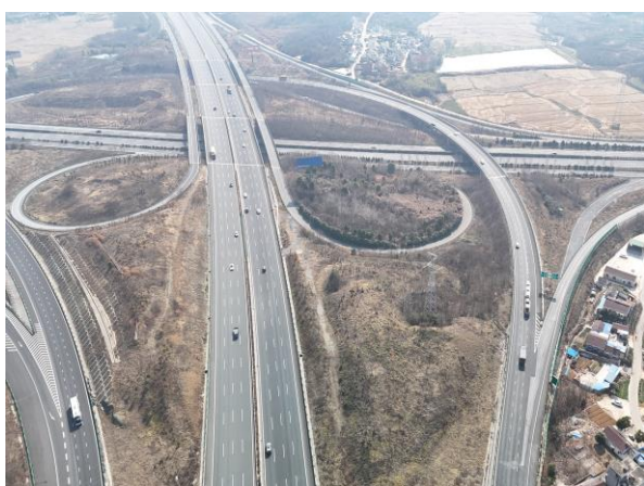
交叉工程区绿化 2
