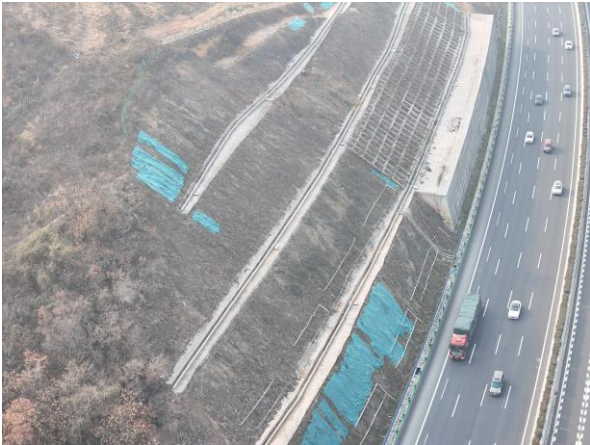
路基工程区骨架护坡、截、排水沟
