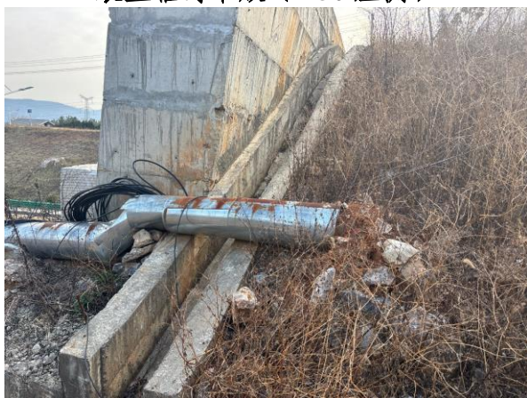
隧道工程区截水沟
